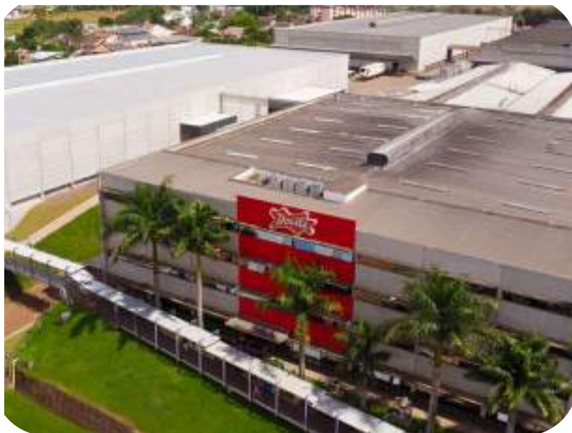
Sul: Lajeado/RS / 88.750m 2
